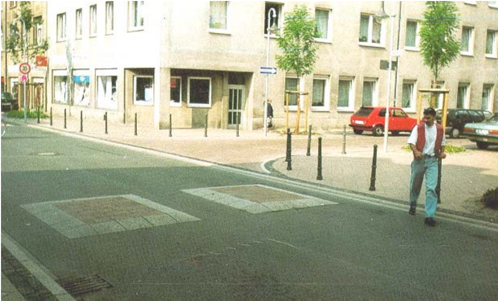
Foto: Carmen Hass-Klau, Geert Böcker, Inge Nold Fonte: Hass-Klau et alii.(1992), Civilised Streets: a guide to traffic calming .
